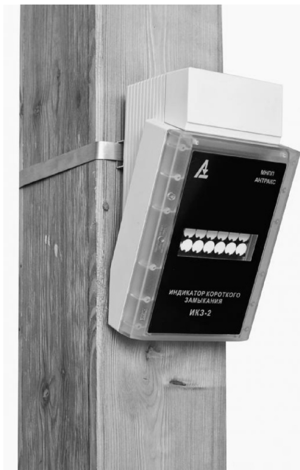
Рис. 37. Размещение прибора ИКЗ на опоре ВЛ
