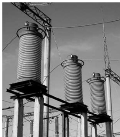
Измерительные трансформаторы тока ТФЗМ
