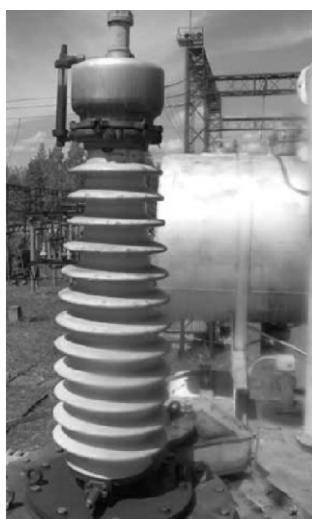
Маслонаполненный герметичный ввод ГБМТ
