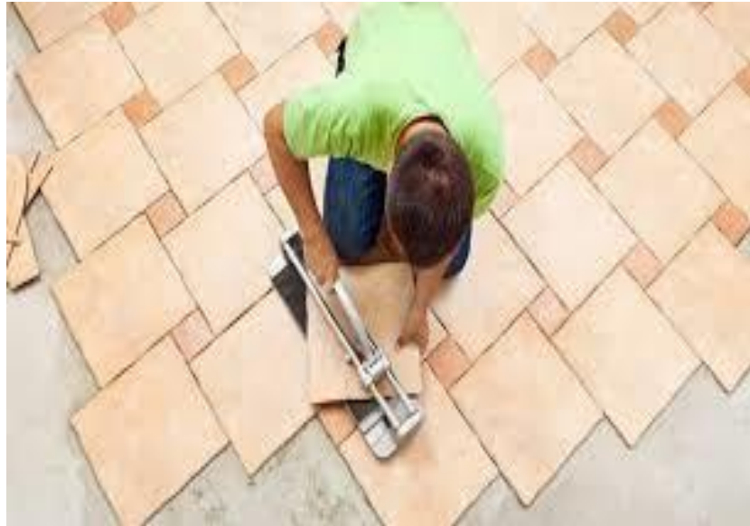
Рисунок 1 Настилка пола комнаты плитками квадратной формы
