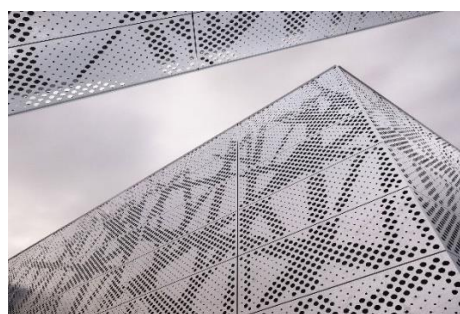
Рисунок 3. Перфорированный металл на фасаде здания
